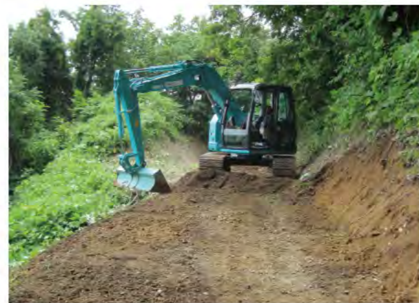
重機による農道整備
